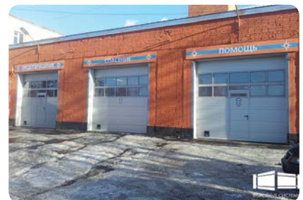
Промышленные секционные ворота.Встроенная калитка. Панорамное остекление на две панели,дает достаточный приток света для освещения помещения днем.
