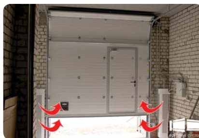
Промышленные секционные ворота с системой отопления, автоматически запускающийся при открытии ворот.
